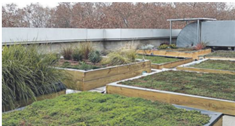
Coberta verda a l'edifici Mercè Rodoreda de la UPF, al campus Ciutadella
